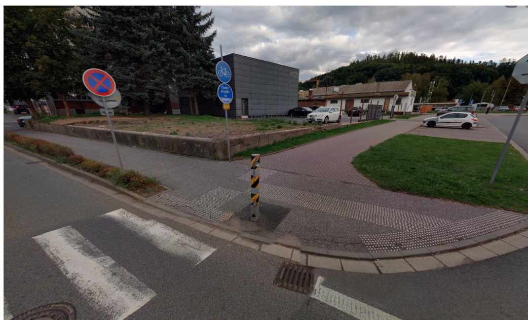
Obr. 4: Hmatové prvky neukončeny na vodící linii
